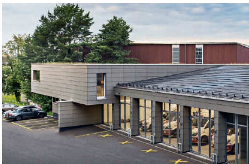
Rettungstrakt des Spital Lachens: ein Gebäude von gestalterischer und technischer Qualität.
