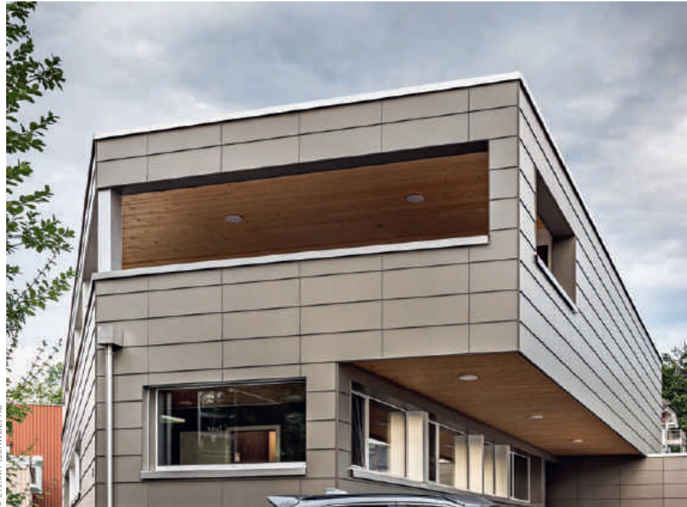
Die Fassade besticht durch eine lasierende Oberfläche.
